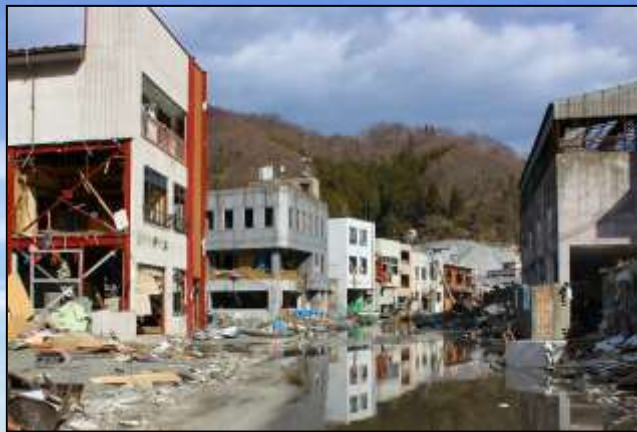
【被災した建築物】
